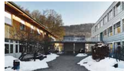
Schulanlage «Räumli» in Spiez
