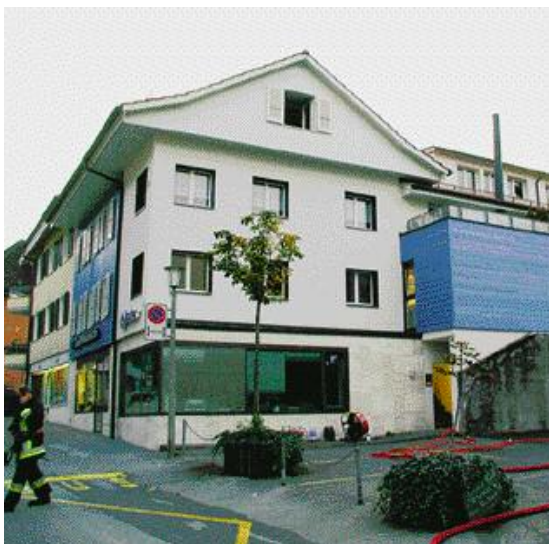
Das Wohn- und Geschäftshaus Brun an der Seestrasse 17 in Spiez.
