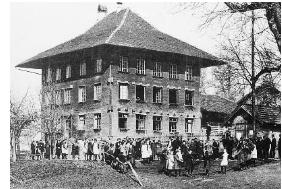
Das Schulhaus «Cafi-Mühli» der Bürgerbäuert Spiez nach der Aufstockung im Jahr 1879
