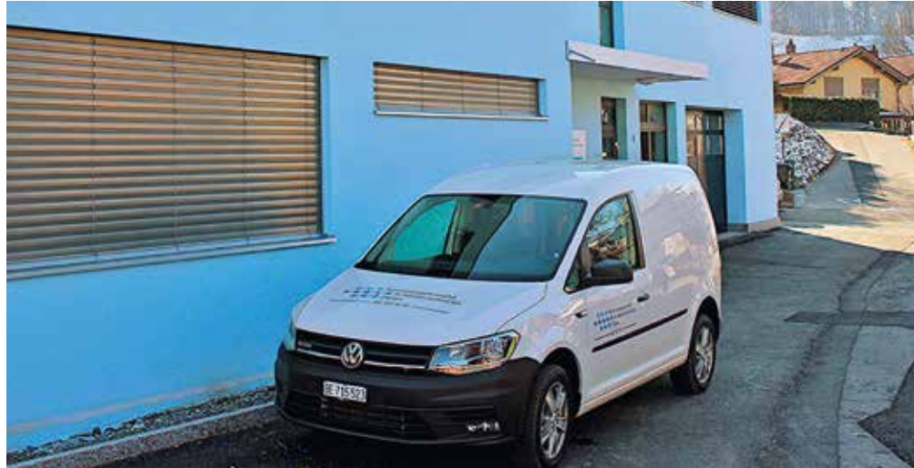
Für die Trinkwasserversorgung im weitläufigen Gebiet der Gemeinde Spiez ist die WVG Aeschi-Spiez - hier ihr neues Betriebsgebäude - verantwortlich.
