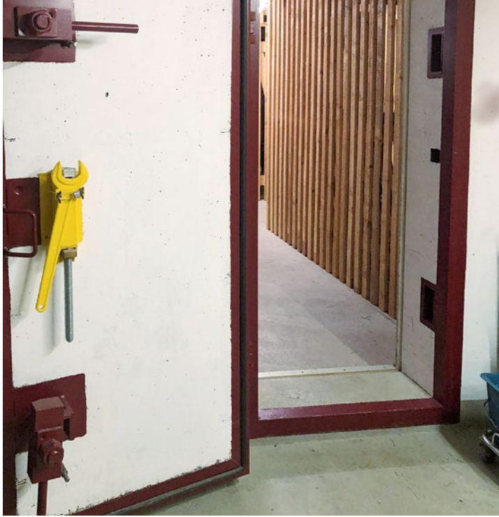
Die Schutzräume müssen wieder kontrolliert werden.
