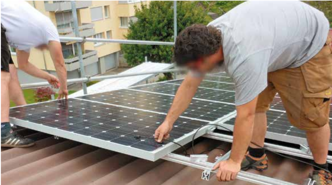
Monteure installieren eine Photovoltaikanlage.
