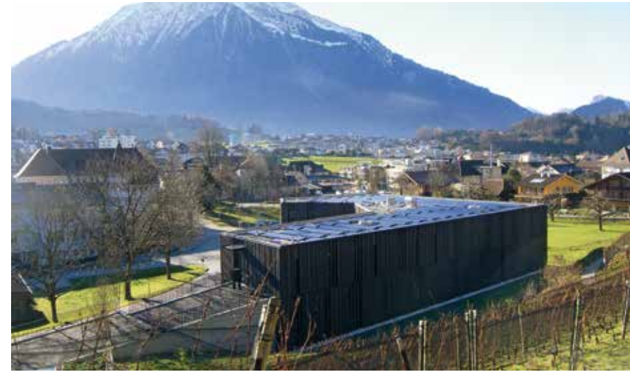
Fotovoltaikanlage auf dem Neubau der Bibliothek in Spiez (Bildrechte Gemeinde Spiez).
