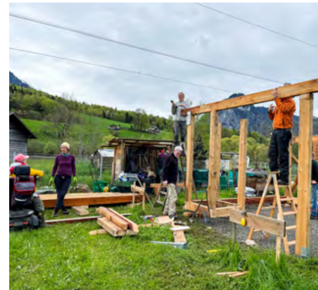
Hier im Spiezmoos ist der Bau des Gartenhauses mit Kompost-WC bald schon vollendet.
