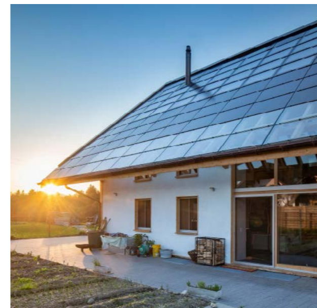
In der Gemeinde Spiez sind über 400 Solaranlagen in Betrieb. Bild: 3S SolarPlus
