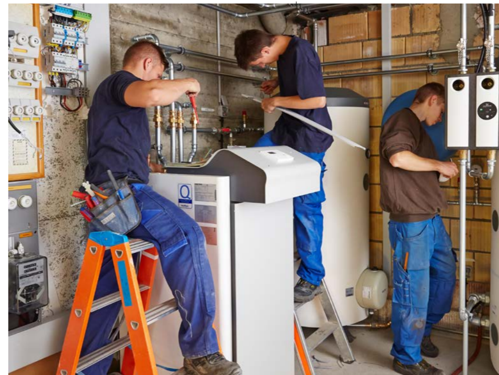
Oben: Wärmepumpeninstallateure «in Action».
