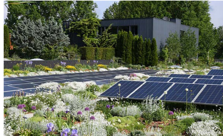
Foto: Fachvereinigung Gebäudebegrünung (SFG)
