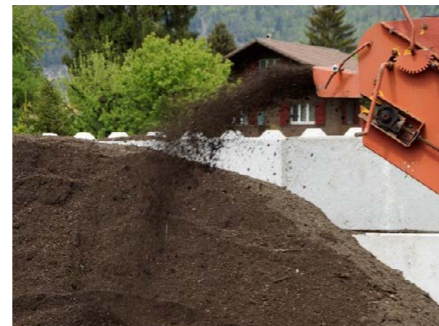
Roger (Zerkleinerungsmaschine) zerkleinert das Erdreich und scheidet sämtliche unerwünschten Materialien wie Wurzeln, Steine etc. aus.
