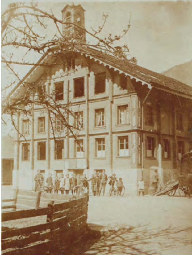
Anonym, um 1905/15. Fotografie der gegen Süden gerichteten Hauptfassade des Schulhauses von 1817/18.
