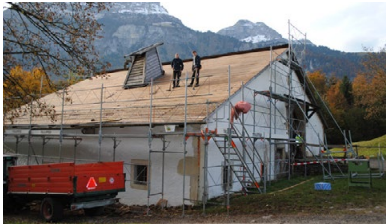
Timon Kappeler und Kenan Bürki auf dem Dach «La Chaux-de-Fonds» nach erfolgtem Abbruch.
