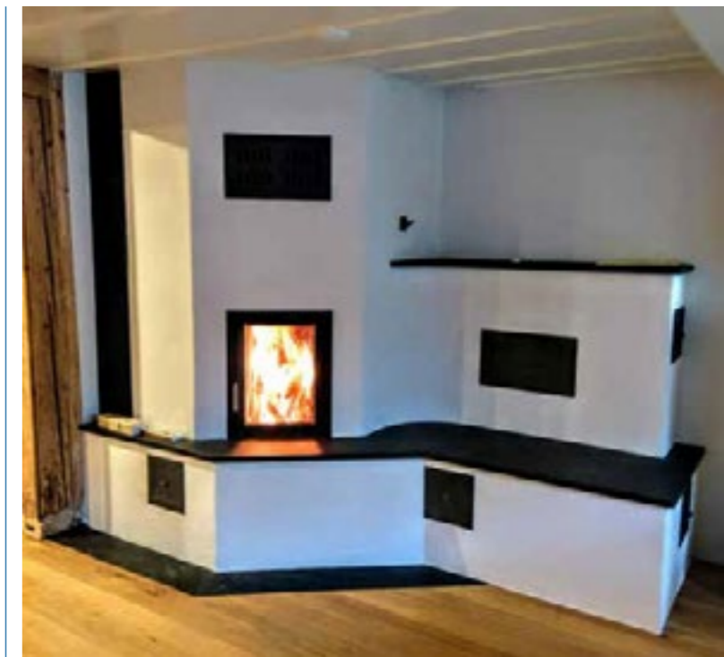
Ganzhausheizung mit Stückholz-Kesseleinsatz in Speicherofen
