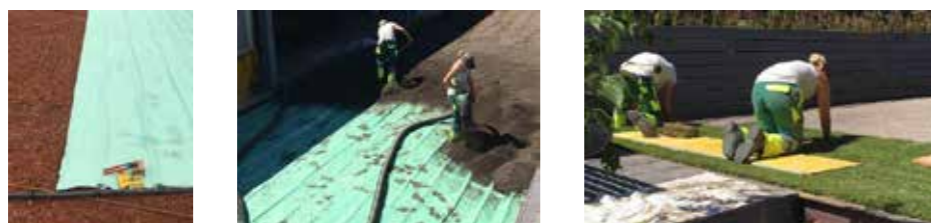
Unterirdische Bewässerungsmatte liefern, verlegen und anschliessen. Abdecken mit Erds substrat. Rollrasen verlegen.
