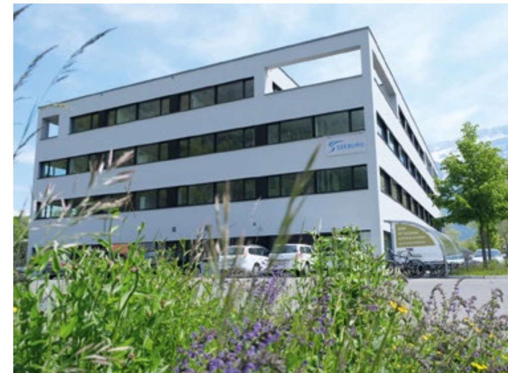
Bild: Seeburg Zentrumsgebäude an der unteren Bönigstrasse 35 in Interlaken.
