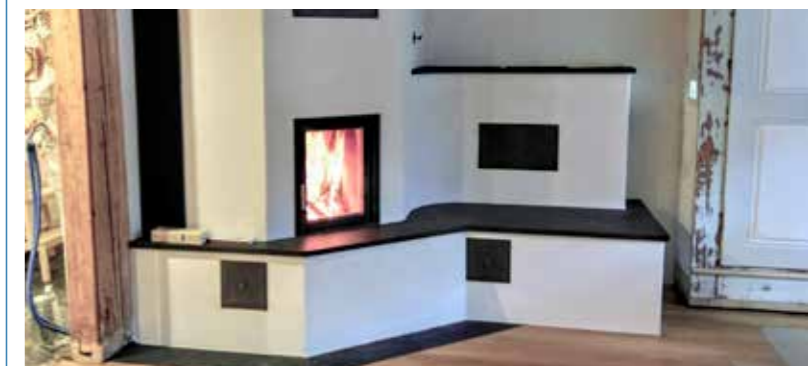
Speicherofen mit Kesseltechnik, Ganzhausheizung
