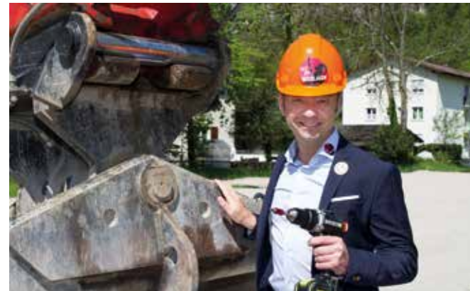
Daniel Beutler, OK-Präsident: Ich bin jeden Tag einmal auf der Baustelle, dem Des Alpes Festgelände.
