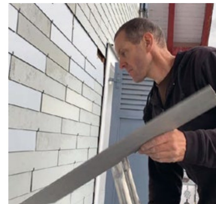
Sanierung einer Eternitfassade nach einem Sturmschaden.
