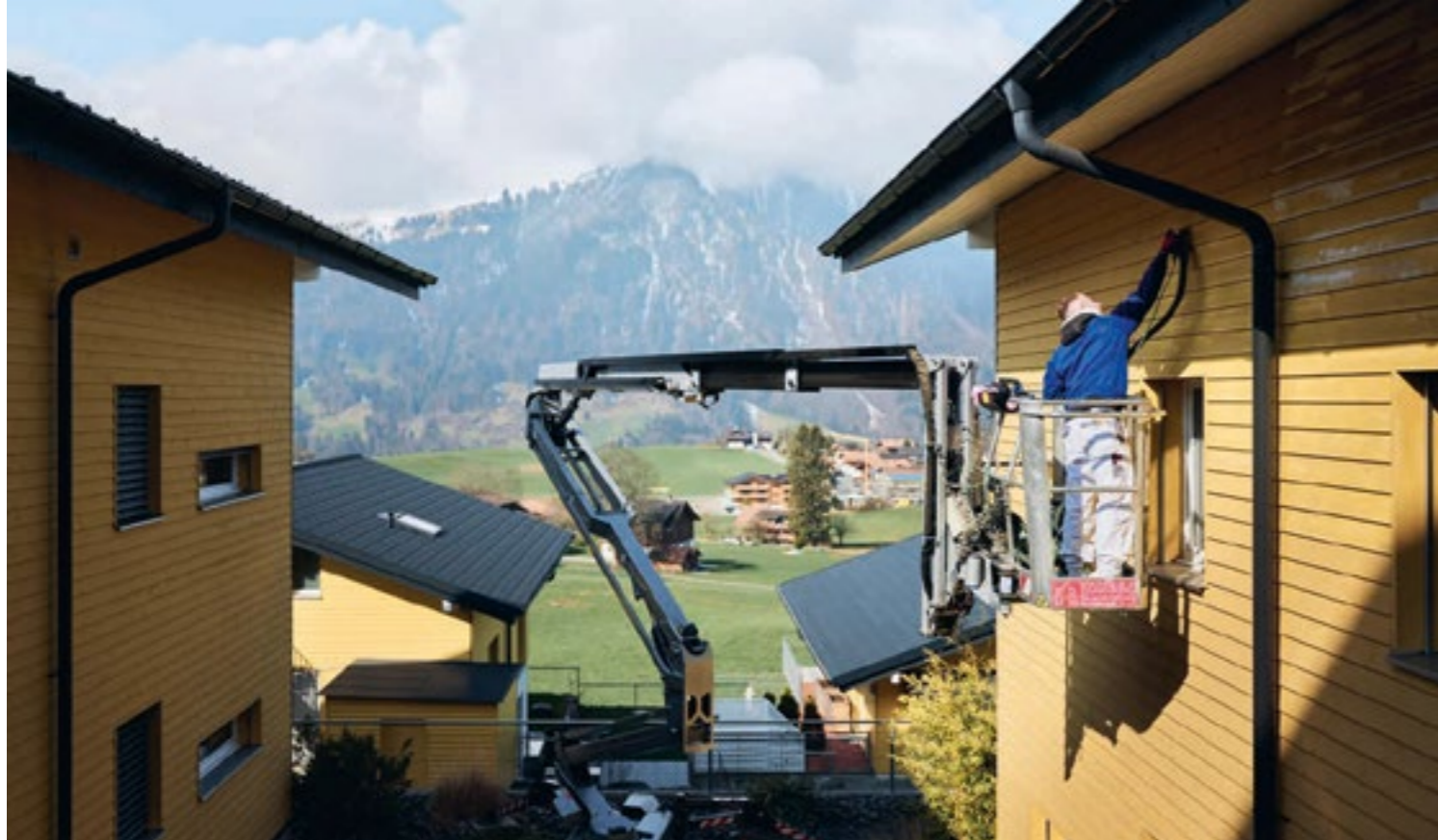
Die Hebebühne in vollem Einsatz vor der Bergkulisse.
