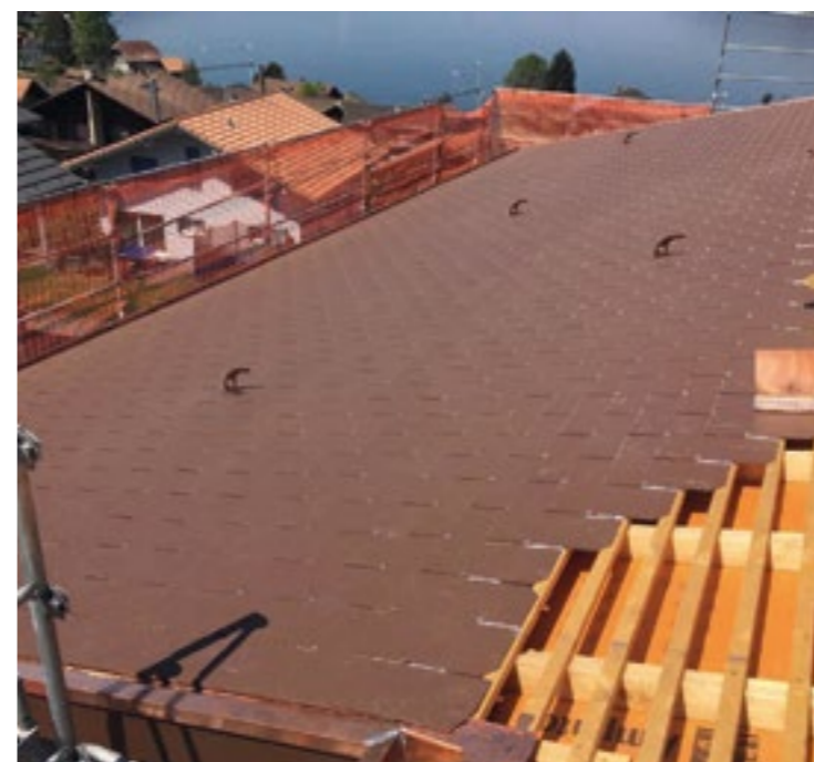
Sanierung einer Eternitfassade nach einem Sturmschaden.
