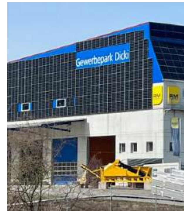
Fassade Industriebau in Hasle-Rüegsau (2024). Foto: SpiezSolar
