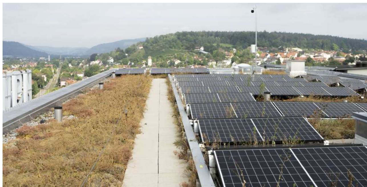
Photovoltaikanlage auf einem Dach im Siedlungsraum.
