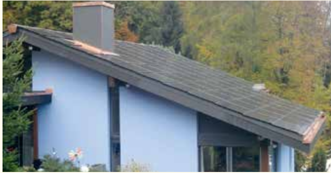
Eine der mittlerweile über 50 Anlagen der EWG
