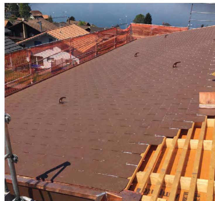
Sanierung einer Eternitfassade nach einem Sturmschaden.
