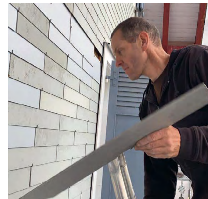
Sanierung einer Eternitfassade nach einem Sturmschaden.
