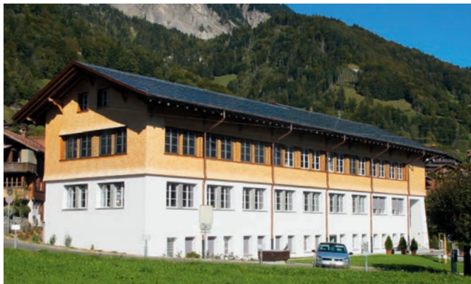
Das sanierte Schulgebäude fügt sich ausgezeichnet in den alten Dorfteil von Brienz ein.
