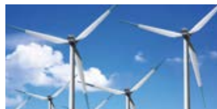
Monitoramento de velocidade de uma turbina eólica
