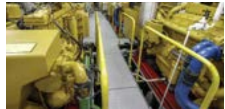
Casa das máquinas em navio
