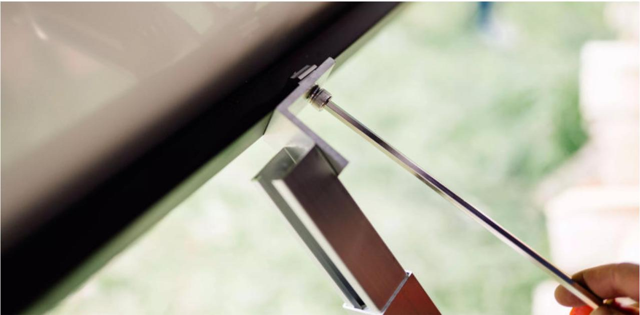
Im nächsten Schritt werden die Wandhalter an die Wand gesetzt. Jetzt werden die Stützen ausgerichtet und anschließend mit jeweils zwei Schrauben und ggf. entsprechenden Dübeln in der Wand befestigt.
