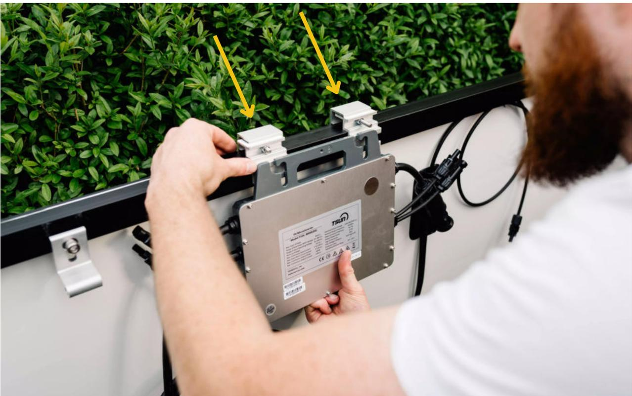
**Schritt 1.2:** Befestige nun die Halterungen am Modulrahmen. Achte dabei darauf, dass die Halterung bei der Montage nicht verkantet, sondern bündig aufliegt.
