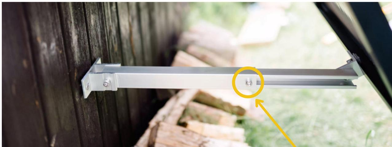
Ziehe nun an allen kurzen und langen Stützen die Gewindeschrauben fest, damit das Modul fixiert ist.
