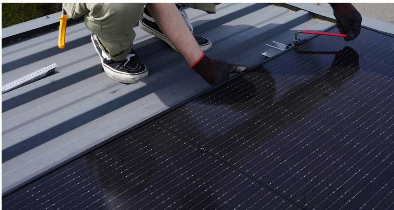
**Schritt 12.2:** Überprüfe das Modul und die Klemmen auf festen Halt, indem du leicht an diesen ziehst.
