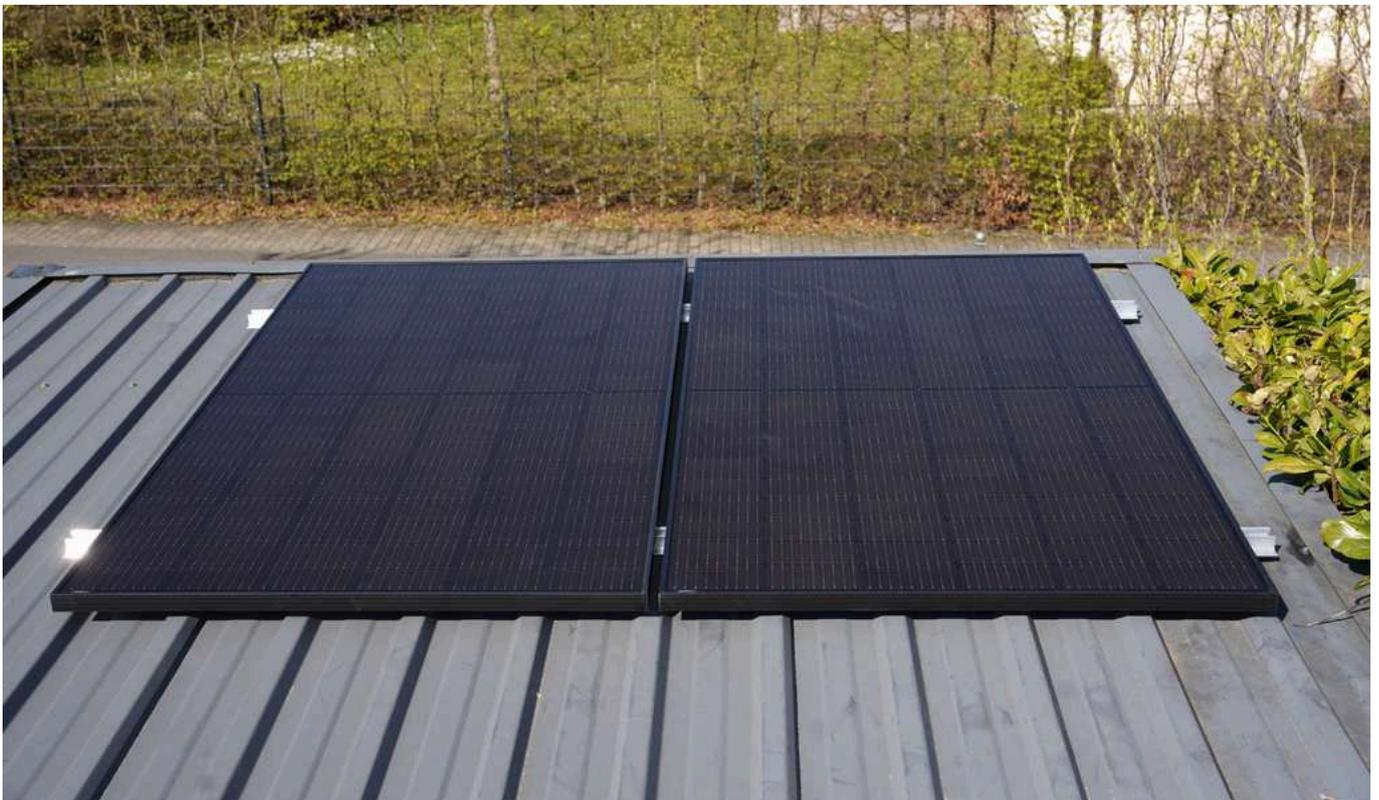
**Schritt 6:** Sollten die Module auf die Kurzschiene angepasst haben, entfernst du die Module noch einmal, um die Kurzschiene mit den Dünnschraube festzuschrauben. Jede Kurzschiene wird mit 4 Schrauben festgeschraubt. Achte beim Festschrauben darauf, dass die Schrauben weder zu fest noch zu locker oder schräg eingeschraubt werden.
