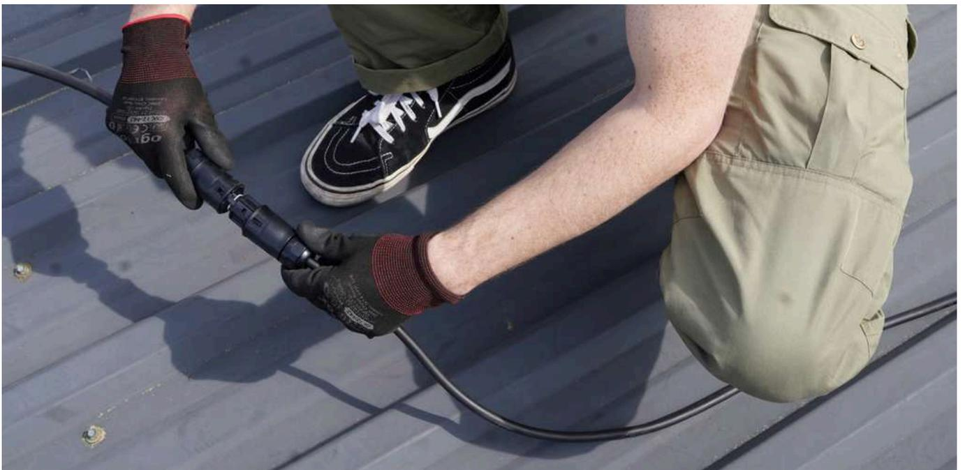
**Schritt 15:** Stecke den Schutzkontakt-Stecker an einem sonnigen Tag in eine Außensteckdose und überprüfe nach 5 Minuten, ob die grüne LED-Leuchte am Wechselrichter blinkt.
