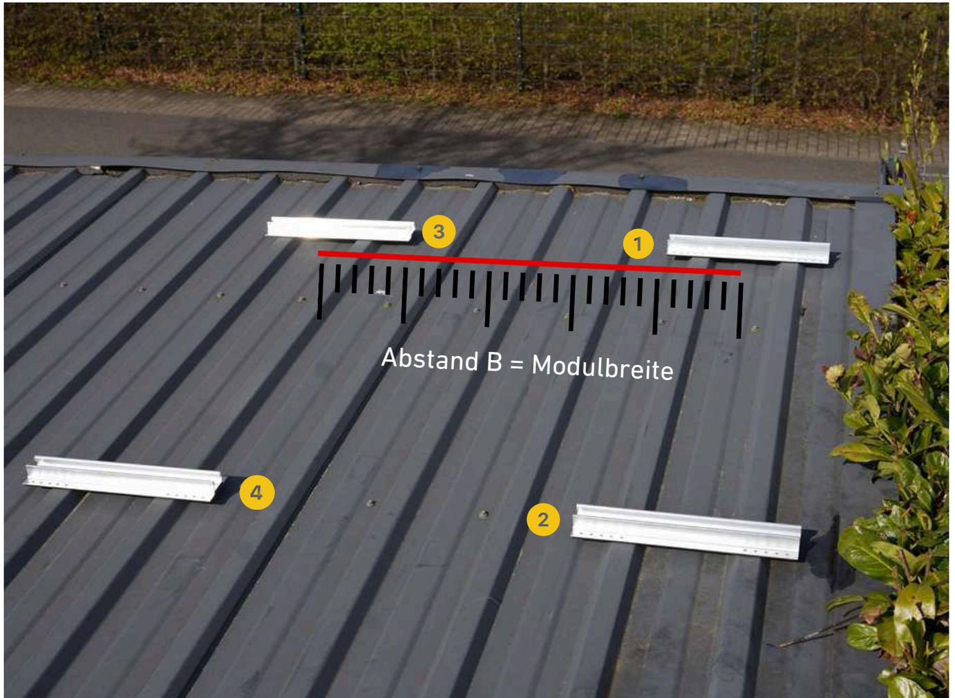
Solltest du ein Balkonkraftwerk mit 2 - 4 Modulen montieren, wiederholst du die Schritte 3 und 4 mit den restlichen Kurzschiene Nr. 5 und Nr. 6 bzw. Nr. 5 bis Nr. 10.
