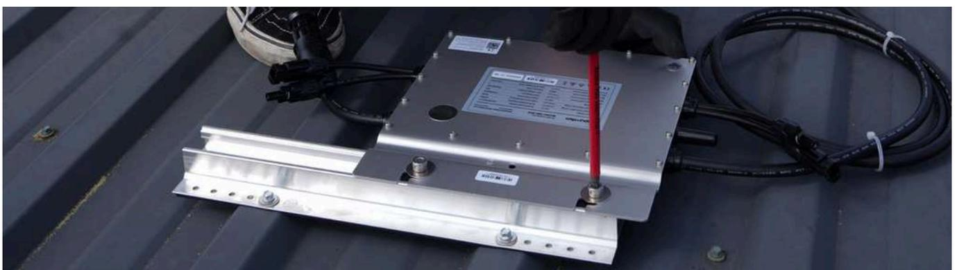
**Schritt 8:** Entferne sowohl vom Wechselrichter als auch von den Solarmodulen die Kabelbinder mit einem Seitenschneider. Achte dabei darauf, dass du die Kabel nicht beschädigst.
