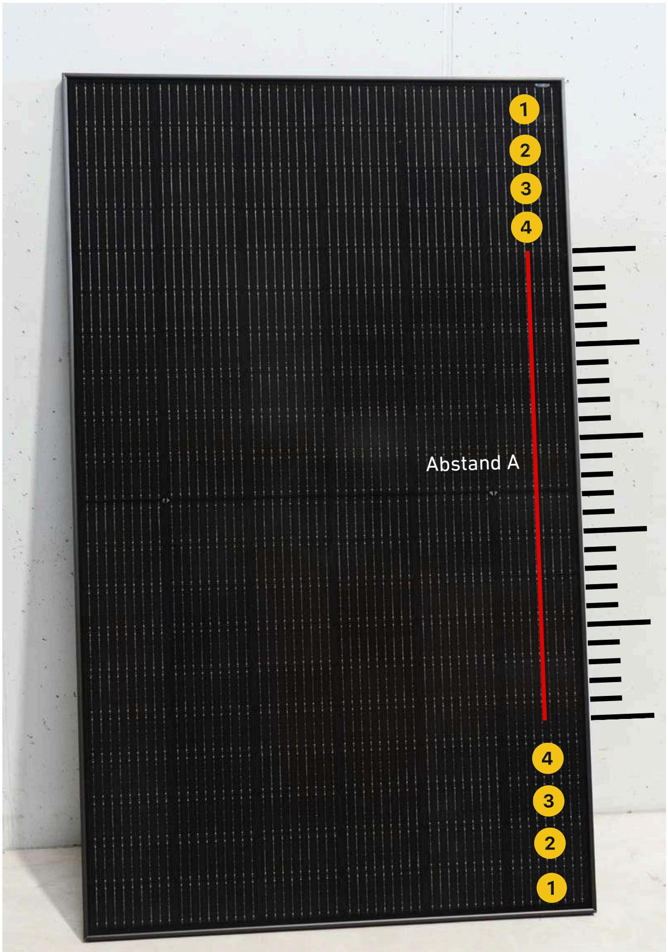
**Schritt 3:** Platziere die Kurzschiene Nr. 1 und Nr. 2 auf zwei Hochsicken so, dass sie in dem gemessenen Abstand A aus Schritt 2 voneinander entfernt liegen.
