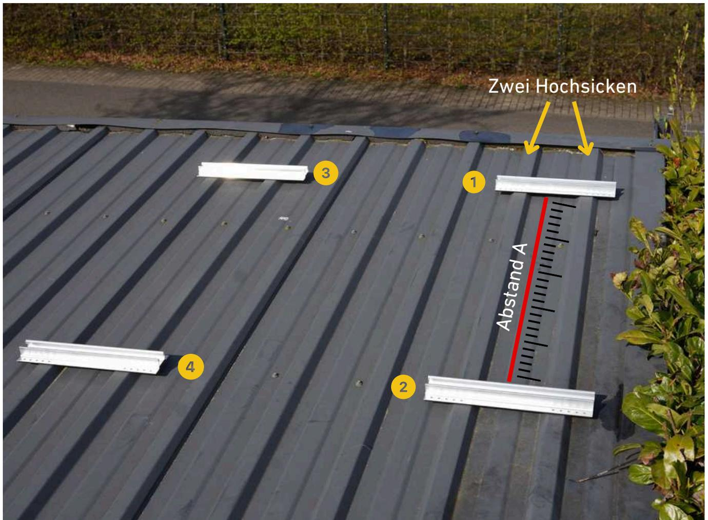
**Schritt 4:** Die Kurzschiene Nr. 3 und Nr. 4 werden parallel zu den Kurzschiene Nr. 1 und Nr. 2 positioniert. Zur Positionierung der Kurzschiene Nr. 3 misst du von der Mitte der Kurzschiene Nr. 1 bis zur Mitte der Kurzschiene Nr. 3. Dieser Abstand B muss der Modulbreite entsprechen.
