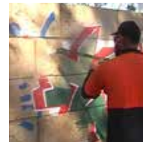
Les graffitis sont éliminés en utilisant uniquement de l'eau chaude à 2000 PSI / 2-3 gallons par minute.
