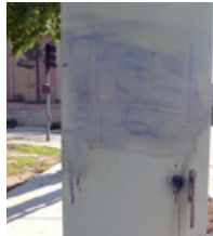
Appliquer au pinceau FPFO
