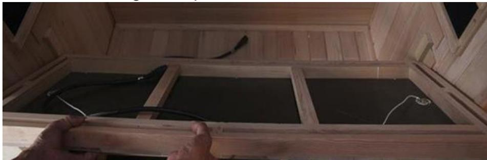
Une fois le panneau émetteur installé verticalement, connectez le cordon d'alimentation CA du panneau de l'émetteur de chaleur du banc au cordon identifié sortant du boîtier de commande. Faites glisser le panneau de banc horizontalement sur le panneau émetteur de chaleur du banc. Assurez-vous de faire glisser horizontalement le panneau de banc complètement vers l'arrière jusqu'à ce qu'il touche au panneau arrière.
