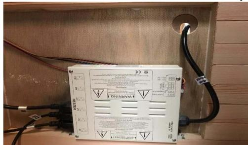
B. Connectez et vissez les connecteurs 'CTRL' ensemble pour alimenter le panneau de commande.
