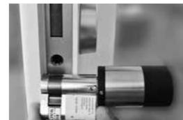
Au montage, il faut veiller impérativement à ce que le panneton se déplace au milieu de la serrure encastrée. Sur les côtés, il ne doit pas être en contact avec la serrure encastrée.
