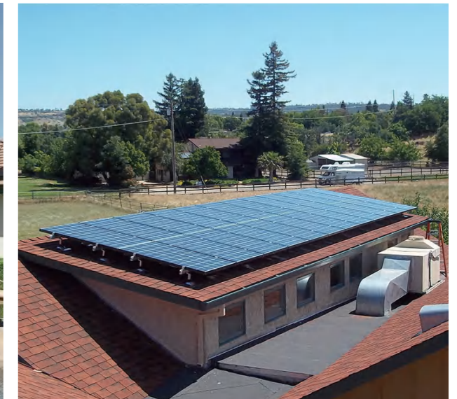
Wohnprojekt in Mexico 5kW
