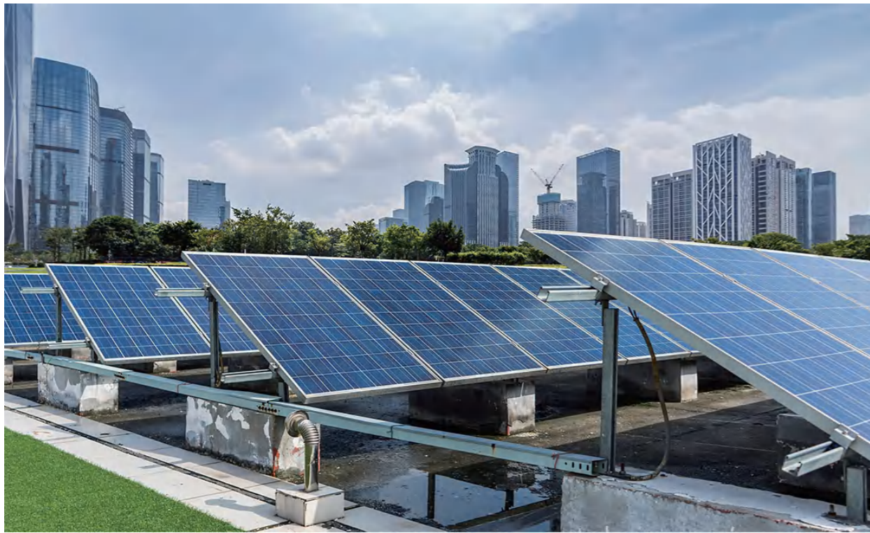
Wohnprojekt in Sweden 10kW
