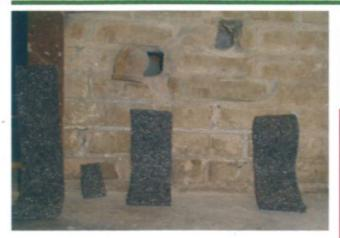
SCHRITT 2: Messen Sie die Breite und Tiefe des Lochs. Schneiden Sie mit einer scharfen Schere ein Stück Xcluder zurecht, das etwas größer ist als die Öffnung (ca. 1 ½ x bis 2x die Breite der Öffnung reicht normalerweise aus).
