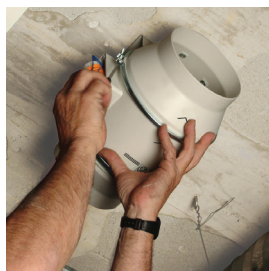
Colocar el cuerpo motor.
