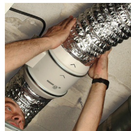
Acoplar los conductos.
