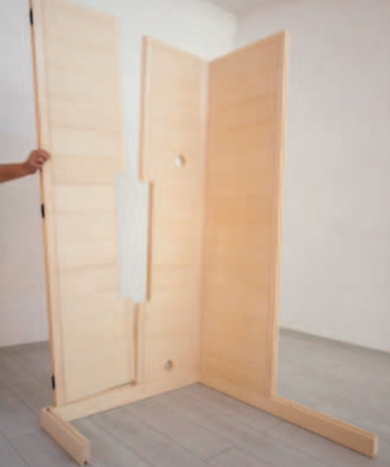
Abb. 6: Wandelement mit Ausschnitt einsetzen
