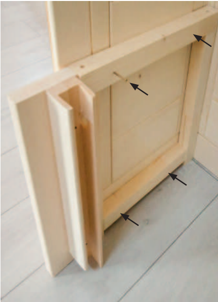
Fig. 18: Montare i supporti della panca
