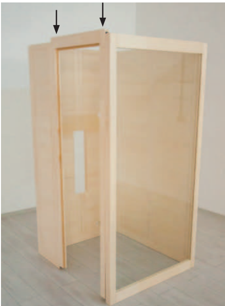
Abb. 10: Montage des Türrahmens
