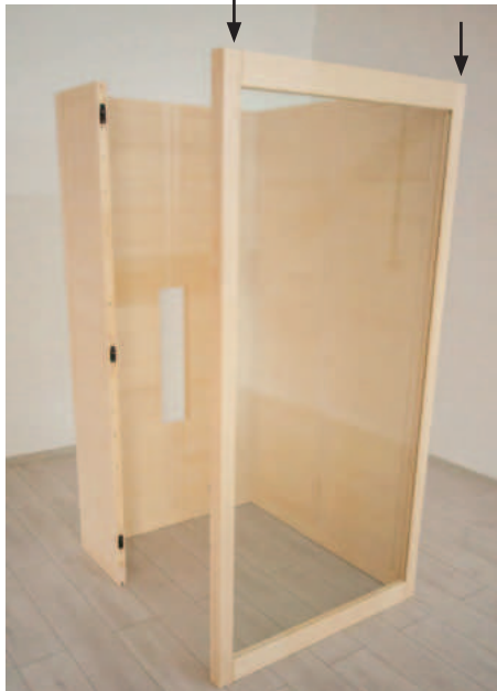
Fig. 10: Montaggio del telaio della porta
