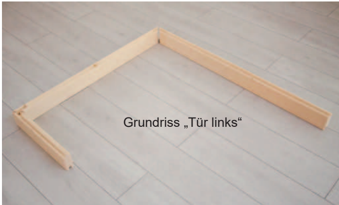
Abb. 1: Auflegen der drei Bodenrahmen-Elemente
