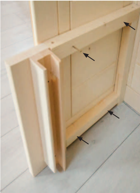
Abb. 18: Bankauflagen montieren
