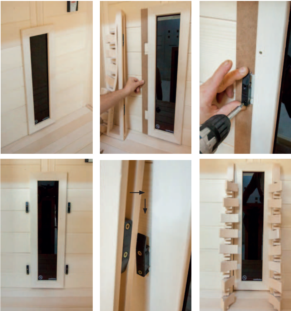
Abb. 29: Montage Rückenlehnen
