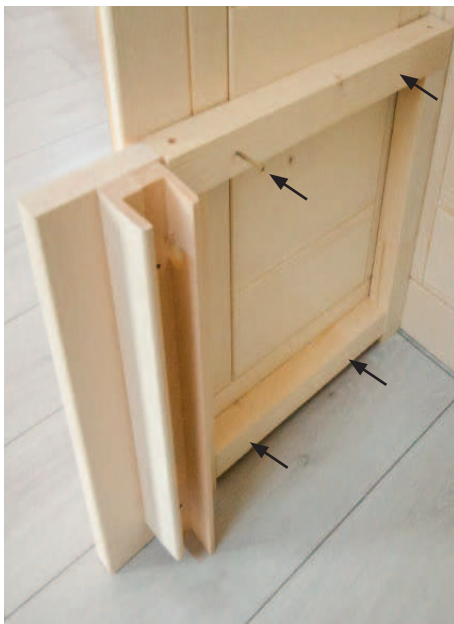
Fig. 18: Montar os apoios do banco
