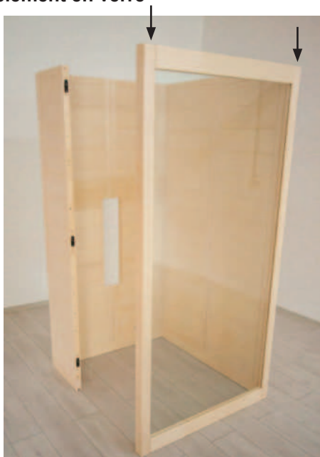
Fig. 10 : Montage du cadre de porte
