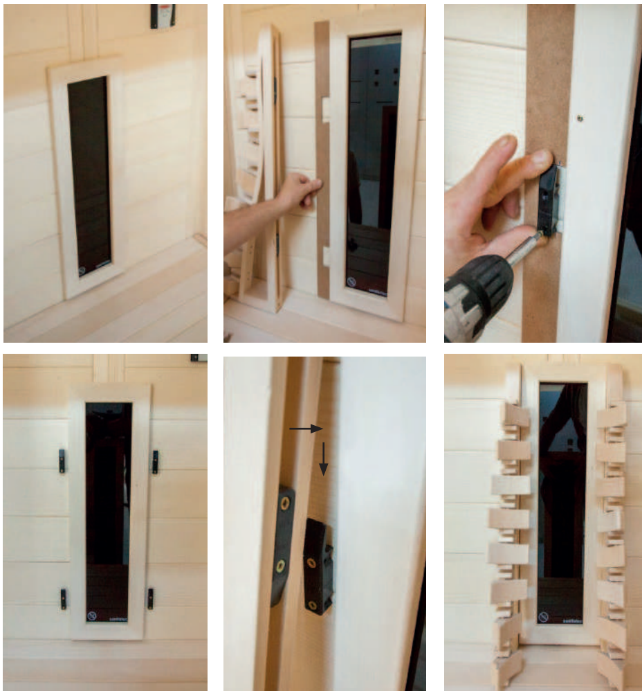
Fig. 29 : Montage des dossiers
