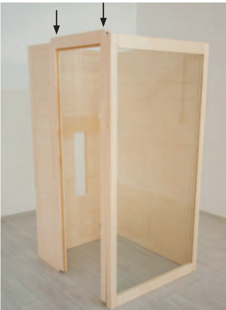
Fig. 10: Installing the door frame
