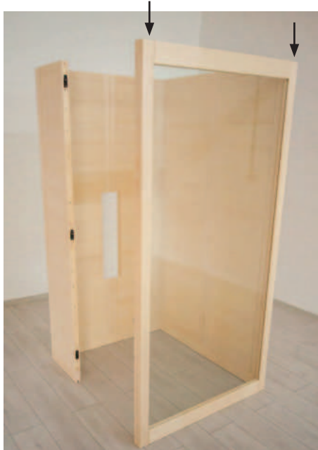
Abb. 10: Montage des Türrahmens
