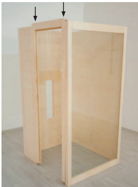
Fig. 10 : Montage du cadre de porte
