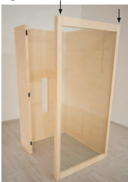
Afb. 10: Montage van het deurframe
