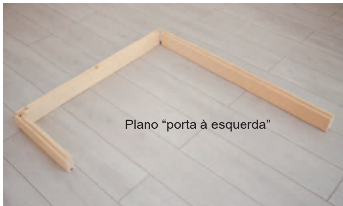
Fig. 1: Instalação dos três elementos da armação do chão
