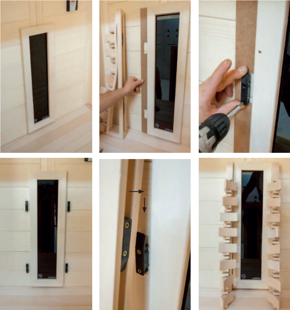
Fig. 29: Montagem dos encostos
