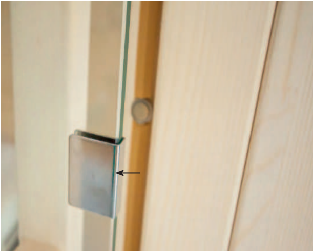
Afb. 35: Montage overschuifplaat
