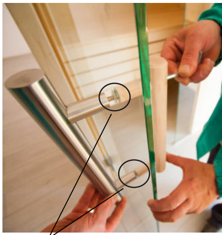
Applicare rondelle di plastica nelle maniglie Nirosta
