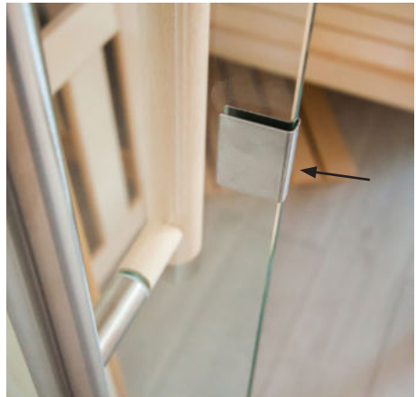
Kunststoff Beilagscheibe bei Niro-Griff beilegen
