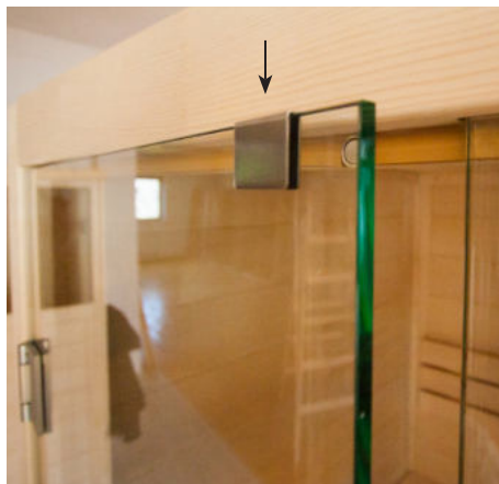
Kunststoff-Beilagscheiben bei Niro-Griff beilegen
