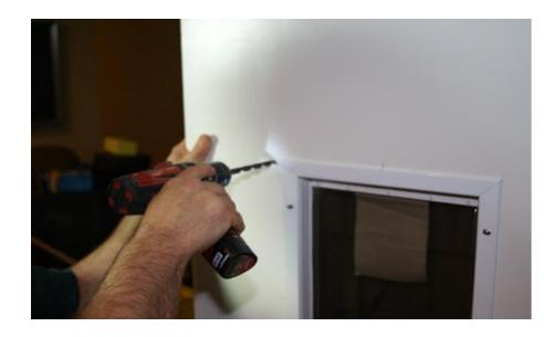
10) INSTALL THE TAMPER RESISTANT SCREW WITH THE INCLUDED BIT (DO NOT TIGHTEN YET, YOU MUST ALIGN AND DRILL THE REMAINING THREE HOLES).
