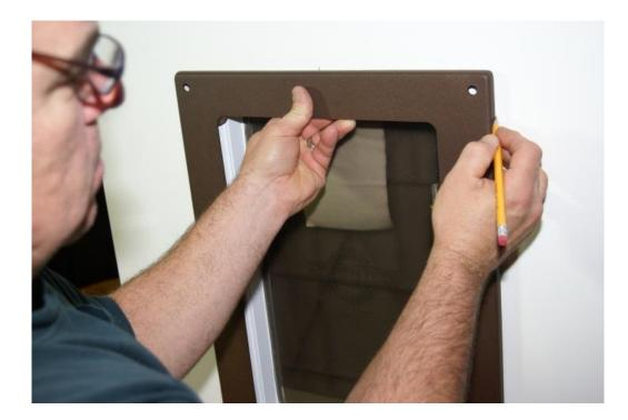
7) NOW USING THE EXISTING PET DOOR, SLIDE THE WATCH DOG SECURITY PET DOOR UP TO THE SIDE OF THE EXISTING PET DOOR AND MOVE IT UP UNTIL THE LINES YOU HAVE MADE ON THE SIDE AND IN THE MIDDLE OF EACH DOOR LINE UP. NOW MAKE TWO MARKS ON THE TOP USING THE NEW DOOR AS A GUIDE.
