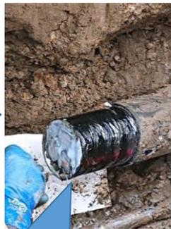
②断面隙間部へコンパウンド充填
