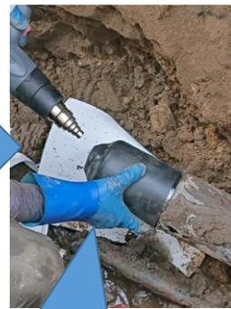
④HSEC収縮チューブの装着と収縮による先端処理
