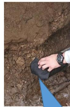
⑤養生カバーDMでの先端の防護（袋とじ）
