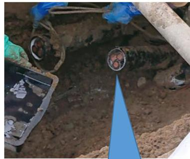
①OFケーブル切断面（先端）の油抜き
