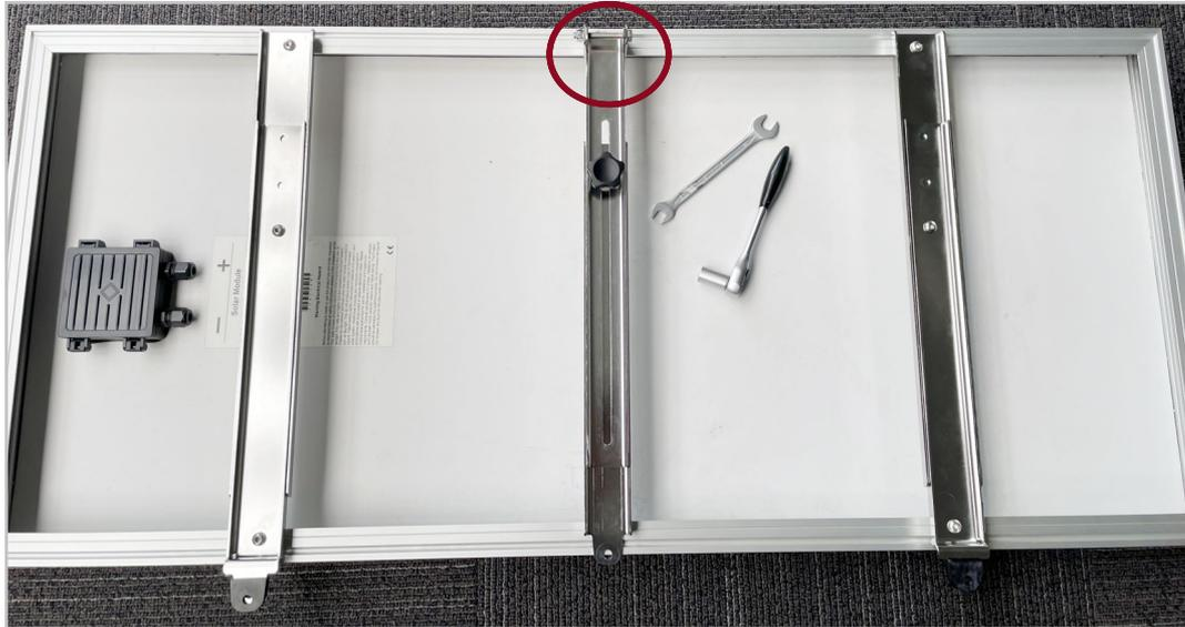
4. Die beiden äußeren Schienen werden am Oberen Relingzug befestigt, dazu die Schellen nacheinander auf den Oberzug der Reling auflegen, Lasche der Halterung zwischen die Schelle führen & fest verschrauben; anschließend die zweite Seite
