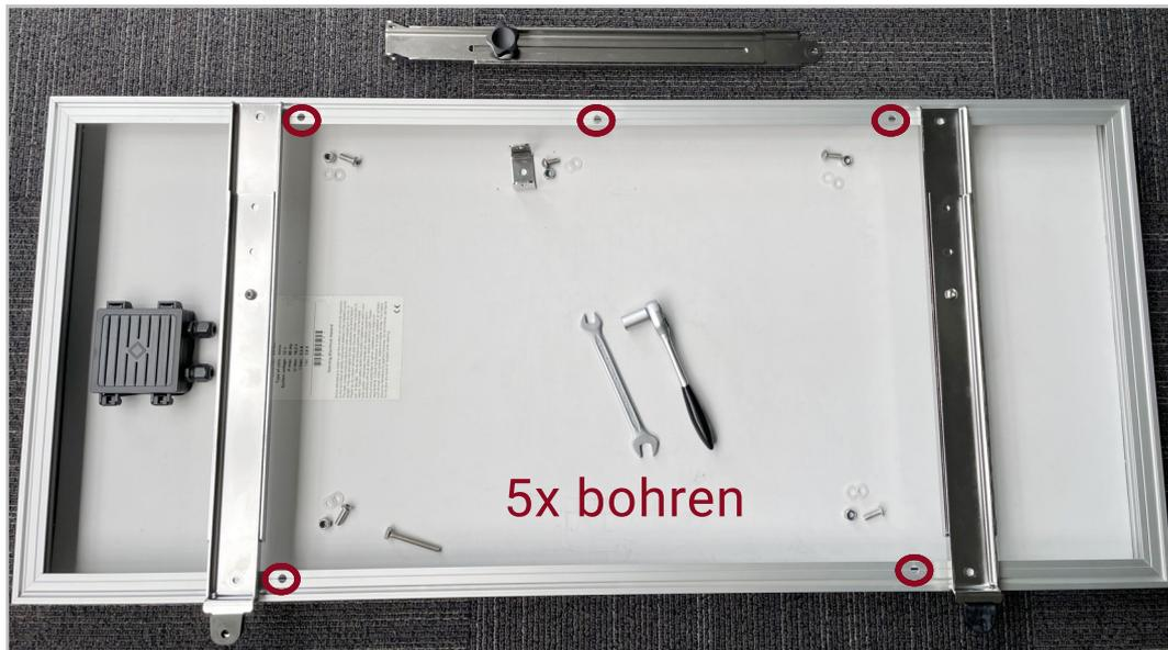
2. Schienen anschrauben, dabei Kunststoffscheiben (im Set enthalten) oben und unten zwischen Aluminium und Edelstahl legen, um Korrosion zu vermeiden; U-Blech an mittlerer Bohrung verschrauben
