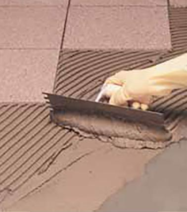
Verlegung von Feinsteinzeugfliesen mit Ultraflex S2 Quick auf der Verbundabdichtung Mapelastic
