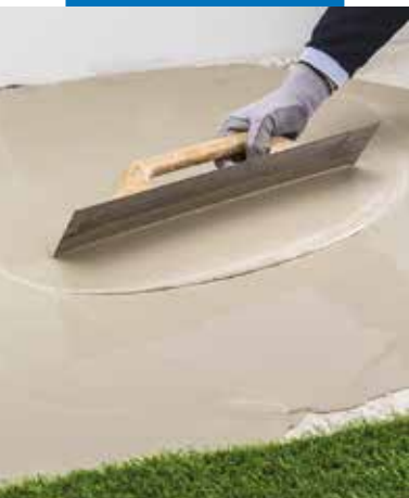
Verarbeitung von Planex HR Maxi im Außenbereich
