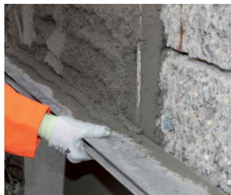
Abziehen von Mapegrout 430 mit einer Latte
