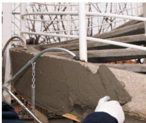
Auftragen von Mapegrout 430 mit einer Kelle
