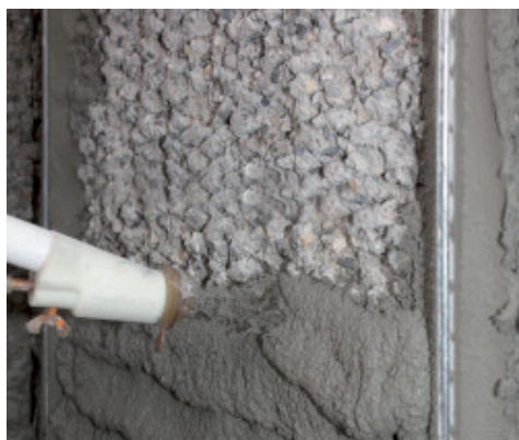
Auftragen von Mapegrout 430 im Nassspritzverfahren
