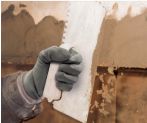
Instandsetzung einer Balkonbrüstung: Reprofilierung des Mörtels
