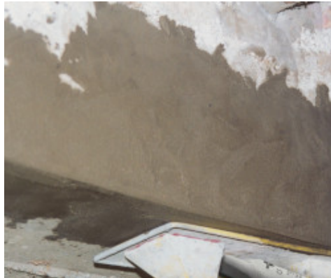
Instandsetzungsarbeiten an einem Betonträger
