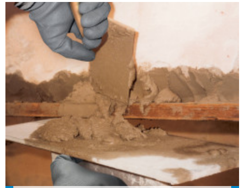
Instandsetzung einer Balkonbrüstung: Einbringen des Mörtels
