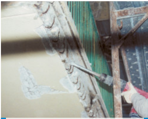
Instandsetzung einer Balkonbrüstung: Untergrundvorbereitung
