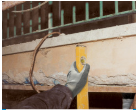
Instandsetzung einer Balkonbrüstung: Berechnung der Mörtelmenge
