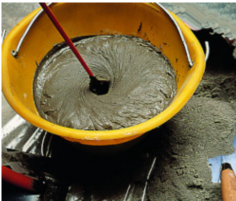
Anmischen von Nivorapid mittels Rührwerk
