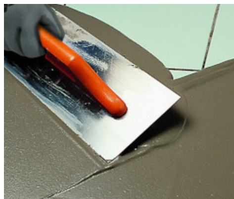
Spachtelung von gereinigten Altbelägen mit Nivorapid
