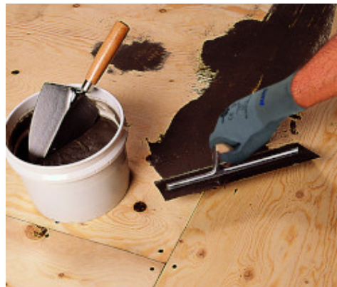
Spachtelung von Sperrholz mit Nivorapid + Latex Plus
