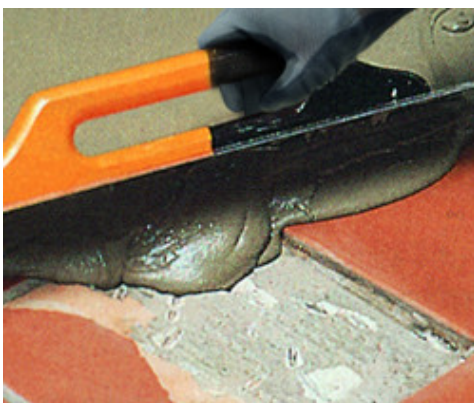
Ausgleich von Fehlstellen im Keramikbelag
