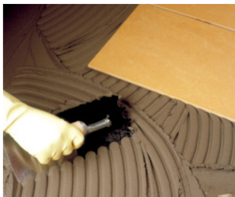
Verarbeiten von Elastorapid mittels Zahnkelle
