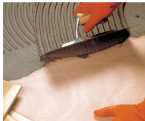
Verlegung von Feinsteinzeug mit Elastorapid
