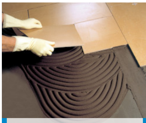
Verlegung von Feinsteinzeug auf einem mit Mapelastic abgedichteten Estrich
