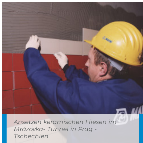
Verarbeitung von Kerabond T im Mrázovka-Tunnel in Prag - Tschechien
