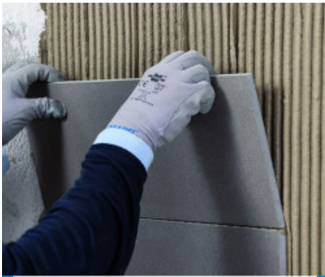
Verlegung von Feinsteinzeugplatten an der Wand
